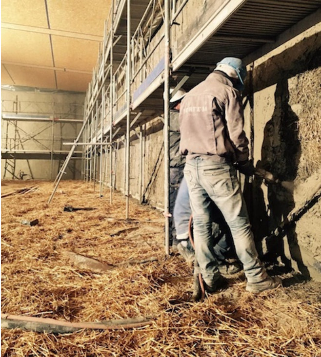
Les balles de paille ont été empilées comme des briques, puis recouvertes de crépi à la chaux. © Achillée.
